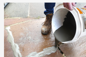
Pour mortar onto wet paving
