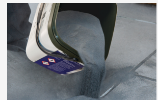
Pour tuffjoint Utility over paving
